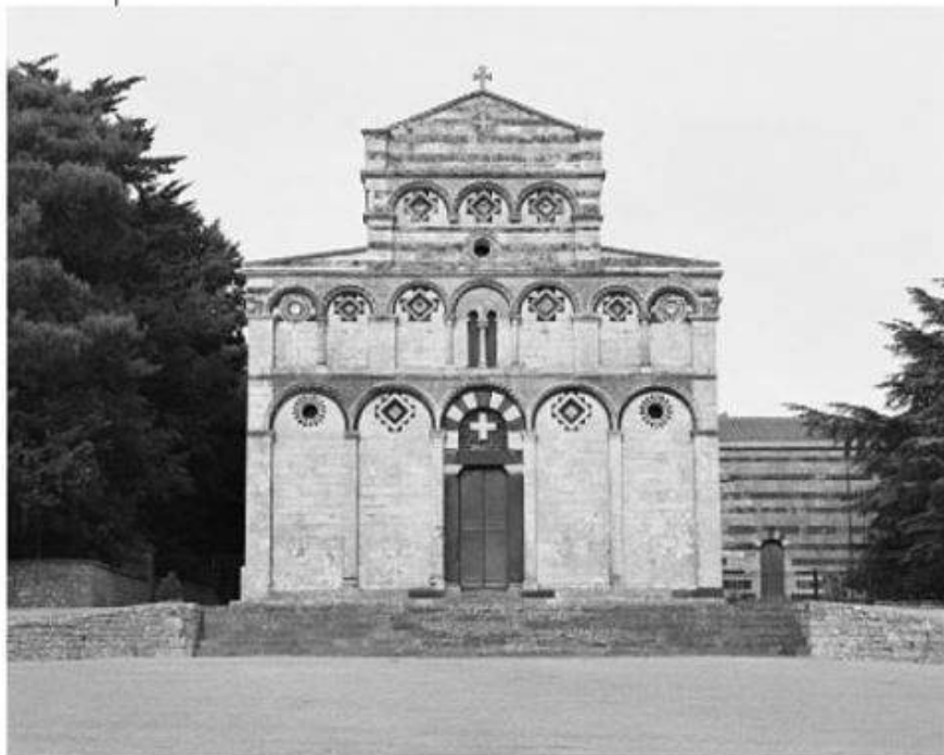
SAN PIETRO DI SOPRES, Borutta (SASSARI) La chiesa sorge su una collina che domina il paesaggio del Meilogu. La bicromia della facciata è data dal nero basalto e dalla bianca arenaria.
